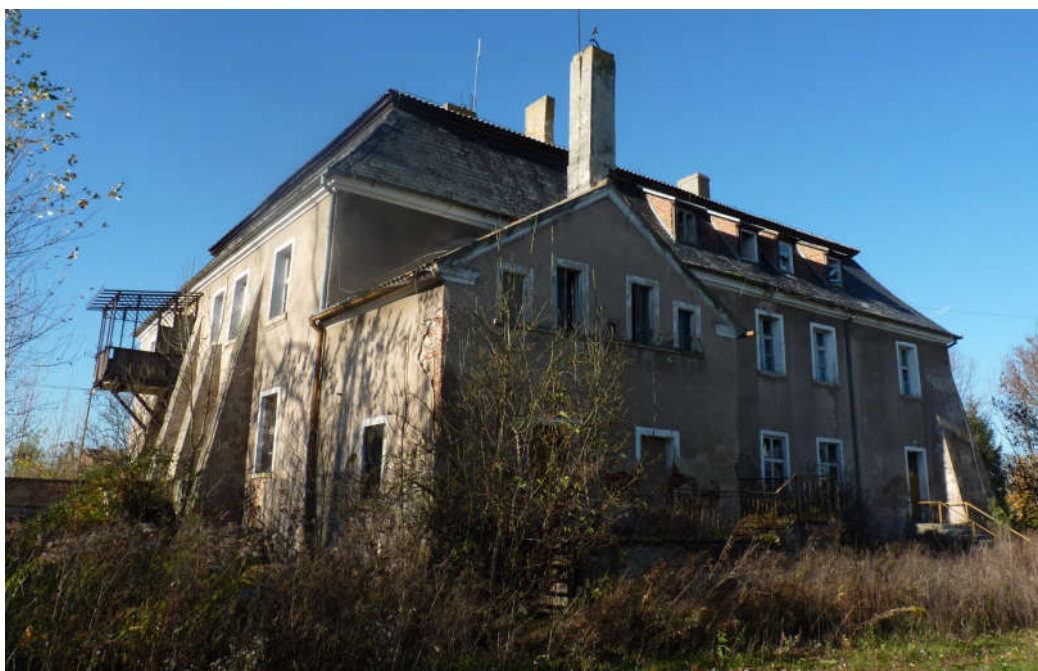
Zespół pałacowo-folwarczny – DWÓR – elewacja północna i wschodnia (rejestr zabytków nr A/3718/776 z dnia 05.10.1960 r.). Autor: Katarzyna Herma Lempart
