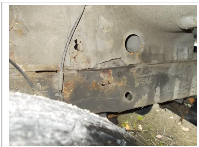
Fot.20. Korozja wnętrza koła PP
